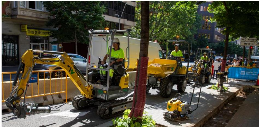
La prueba ha comenzado en la calle Balmes, entre Diagonal y Córsega, donde se sustituyen canalizaciones de Aigües de Barcelona (Cesar Rangel)
