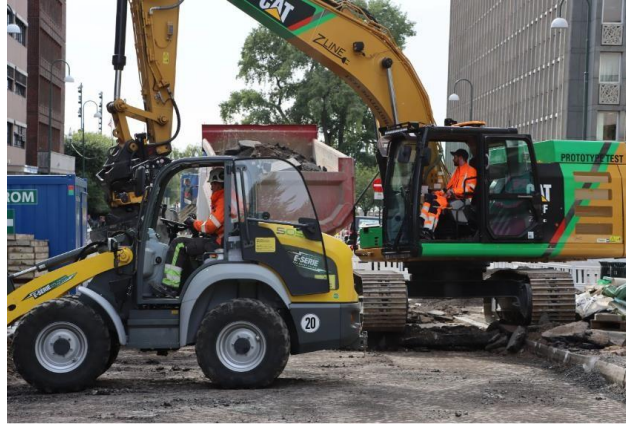
Figura 4. Excavadoras y cargadores eléctricos usados en la obra Fuente. (KlimaOslo, 2019b)
