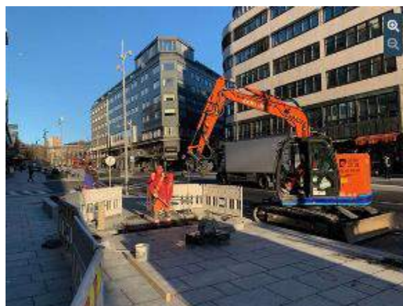
Figura 1. Sitio de construcción de emisiones cero en el centro de Oslo.
