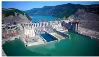
Fuente de energía
