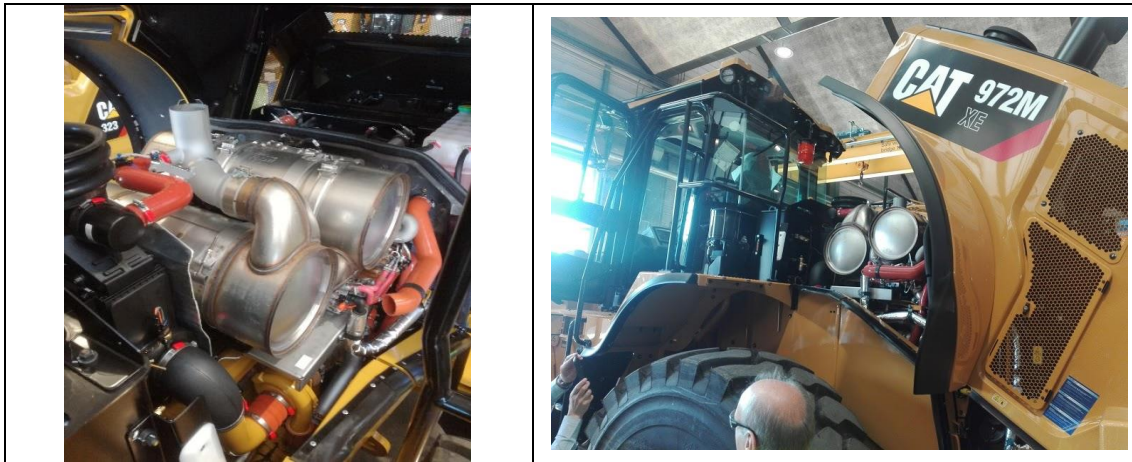
Figura 4: Motor Caterpillar estándar Stage V de un cargador frontal con sistema de control de emisiones DPF y SCR.
